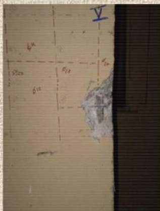
VERIFICA ARMATURA; RILIEVO CON PACOMETRO (PROFOMETER 5),
