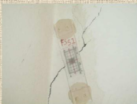
MONITORAGGIO FESSURE E CREPE CON FESSURIMETRO
